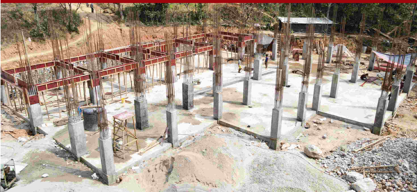
निर्माणाधिन प्रशासकीय भवन
